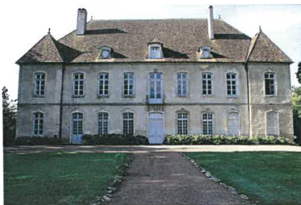
Façade Nord, UDAP70/90
