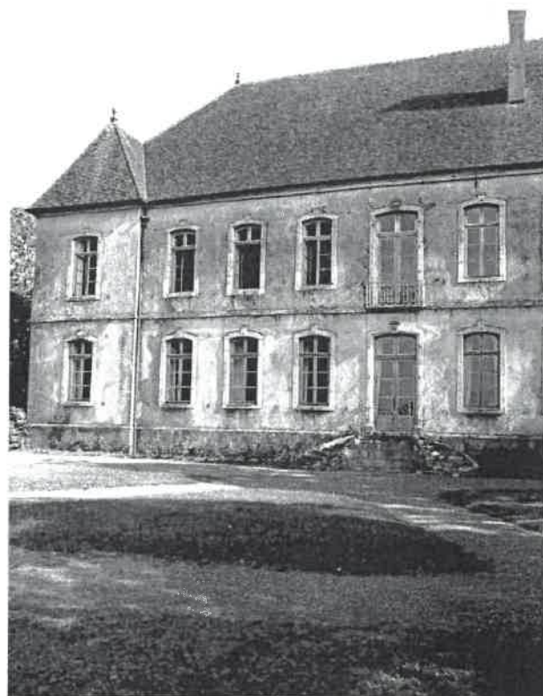
Façade Nord, UDAP70/90
