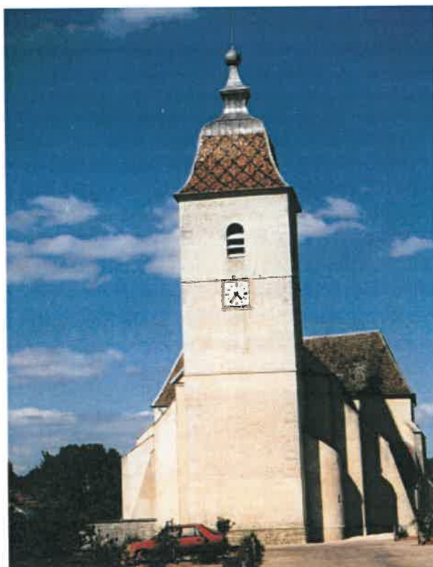
Clocher, façade ouest, UDAP70/90
